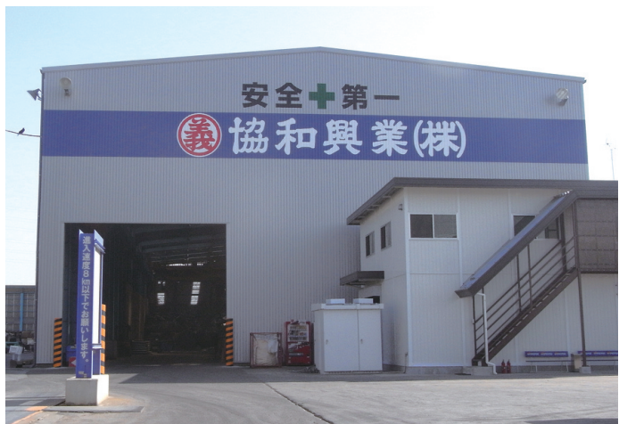
全面リニューアルしたメイン工場棟
