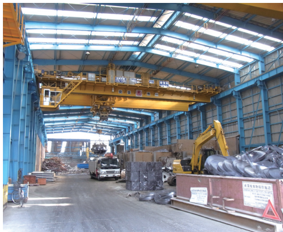
天井に採光板を設置。日中は照明が無くても明るい
