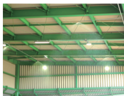
建屋内の防塵ミスト
